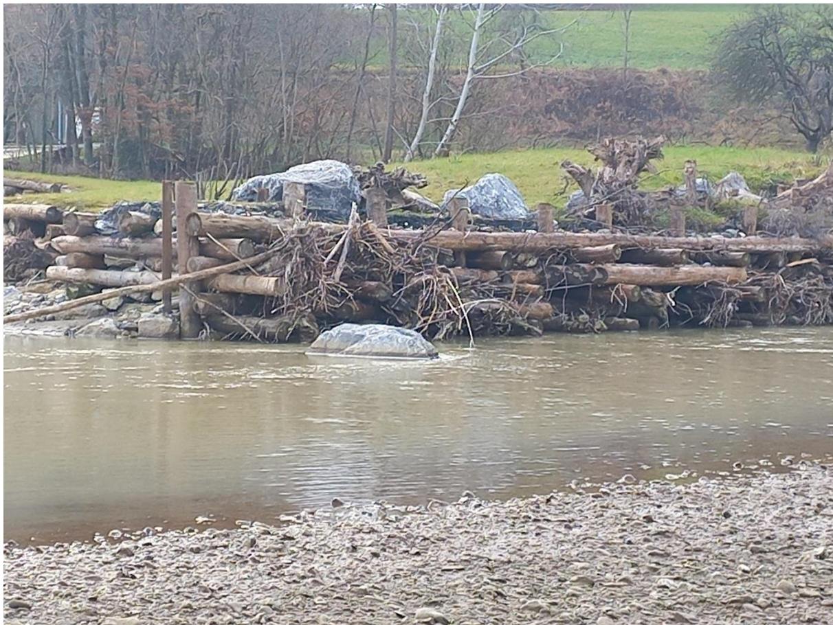
Slika 18: Luknje in previsi nastali pod obstoječim zavarovanjem brežine z lesenimi piloti, koreninskim sistemom in skalami samicami predstavlja pomembno skrivališče za ribe. Vodotok: Savinja. Foto: arhiv, ZZRS.
