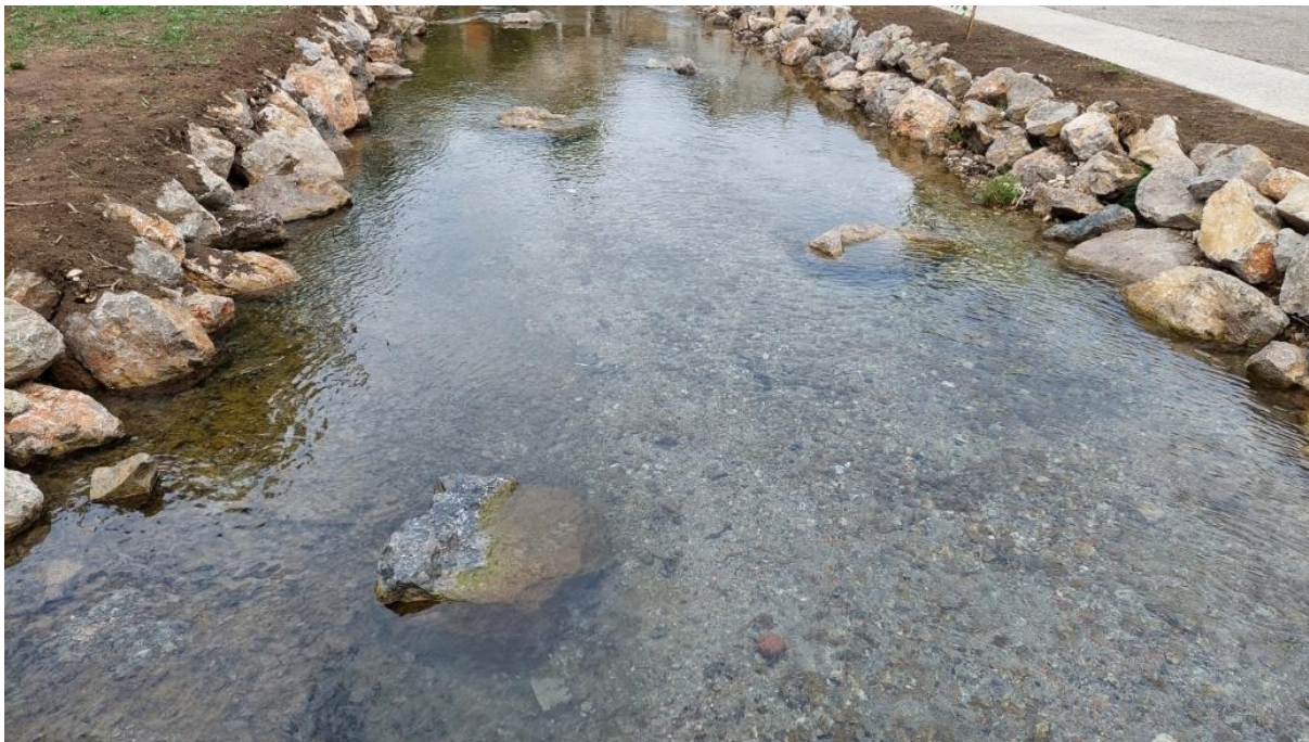
Slika 5: Neparavno zavarovanje brežine, brez uporabe betona. Vodotok: Bistrica (Ilirska Bistrica). Foto: Arhiv ZZRS.
