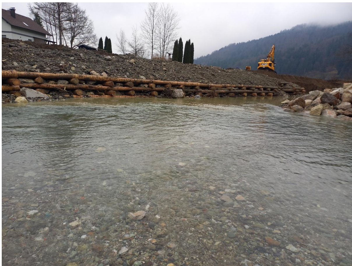
Slika 14: Zavarovanje brežine s kašto. Vodotok: Savinja. Foto: arhiv, ZZRS.
