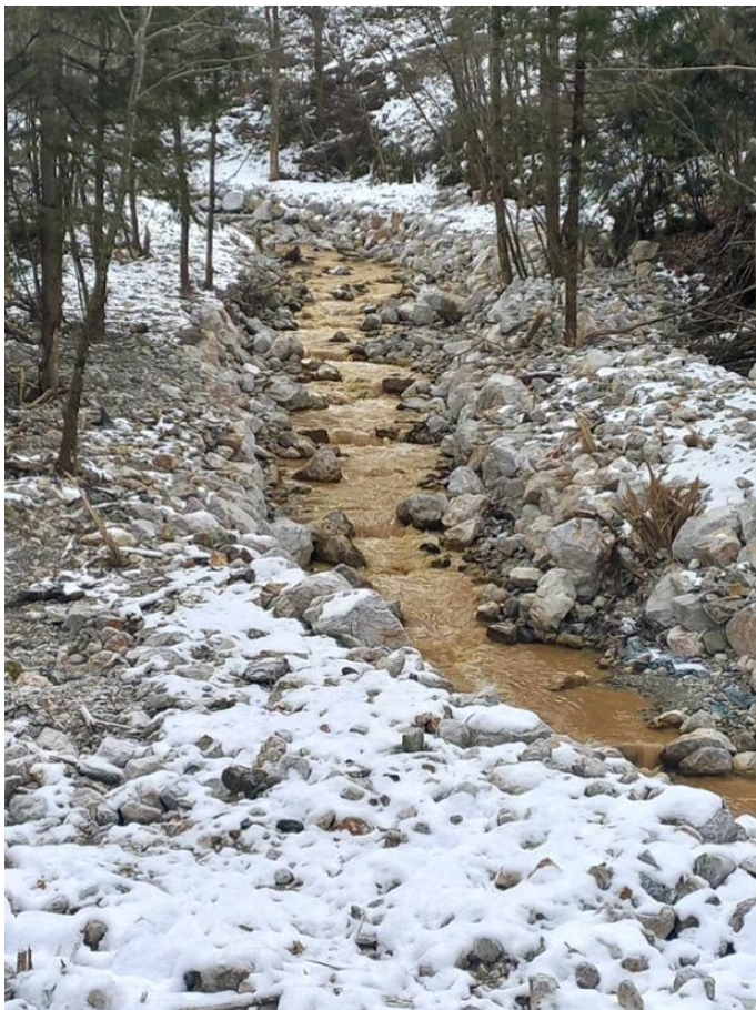
Slika 8: Nепoravnano izvedena zložba v suho. Vodotok: Črna. Foto: arhiv, ZZRS.
