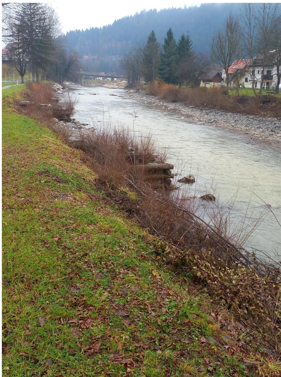
Slika 16: Zavarovanje brežine z jezbicami zasajenimi z vegetacijo. Vodotok: Savinja. Foto: arhiv, ZZRS.
