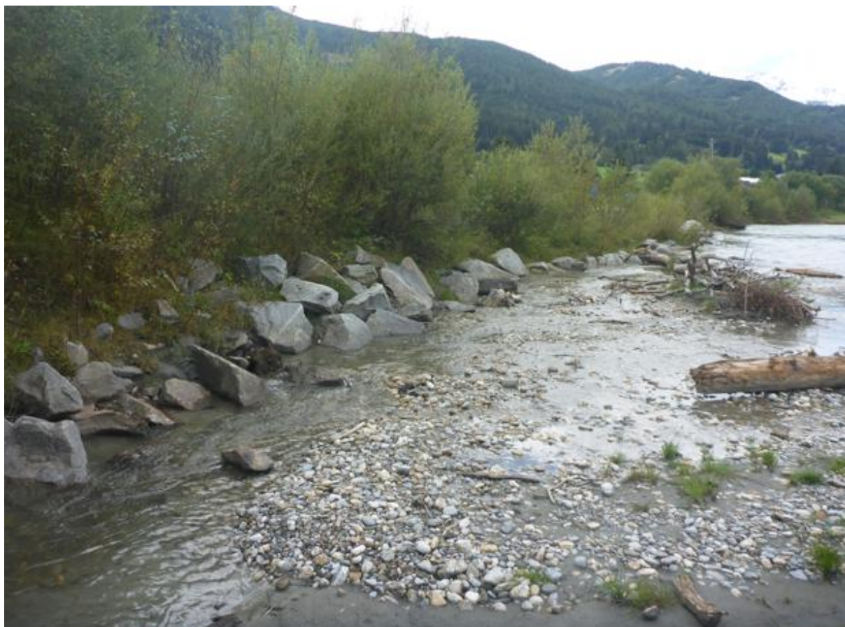
Slika 7: Sonaravno zavarovanje brežin s kamnometom. Vodotok: Mura (Avstrija). Foto: arhiv, ZZRS.
