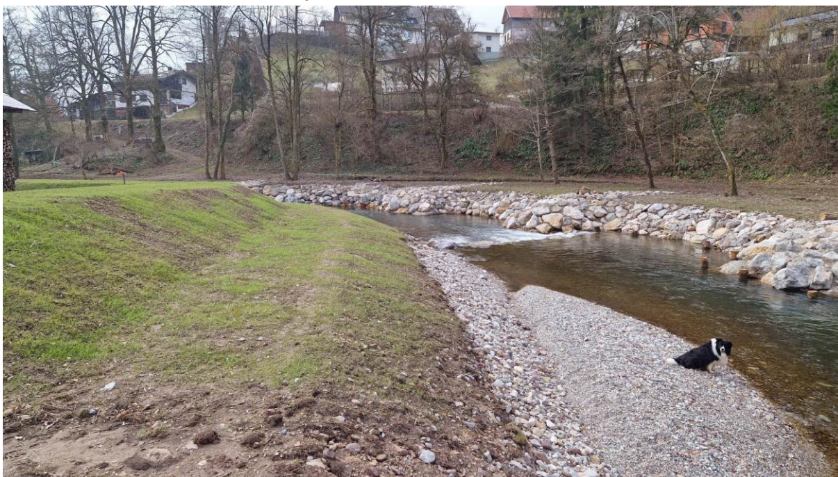
Slika 22: Širitev struge izvedena na način dvojnega trapeza. Vodotok: Božna. Foto: arhiv, ZZRS.
