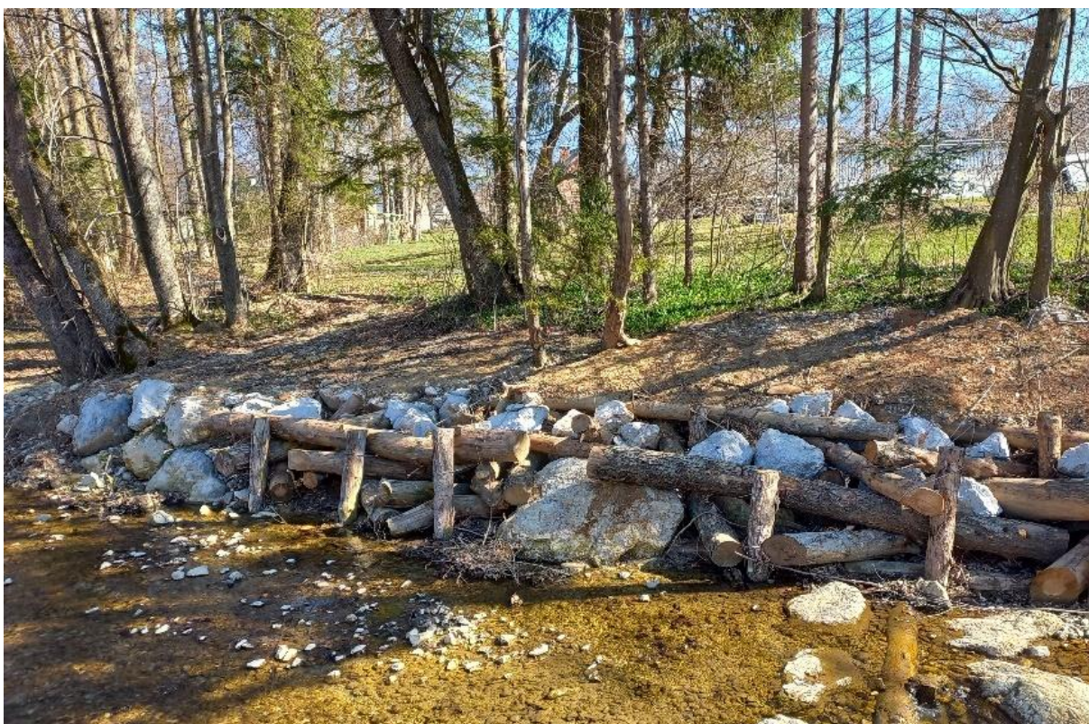
Slika 6: Sonaravno zavarovanje brežine z lesenimi piloti in skalami. Vodotok: Milka. Foto: Arhiv, ZZRS.
