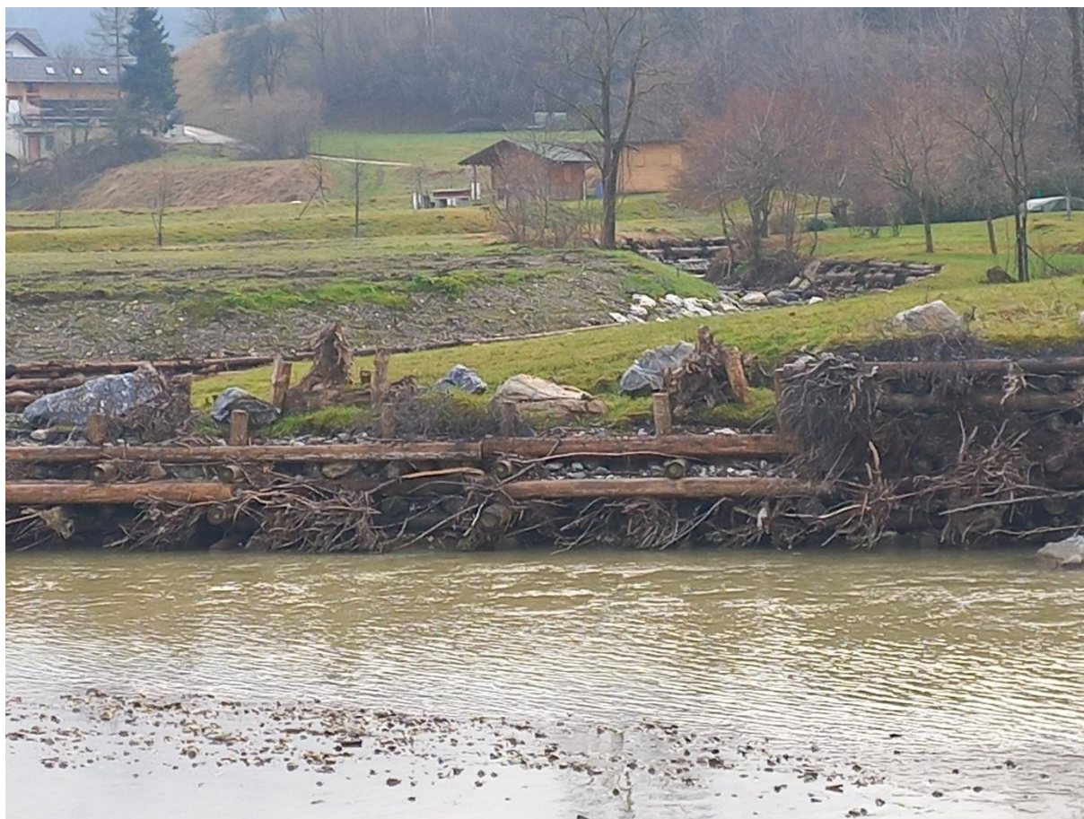
Slika 13: Zavarovanje brežine izvedeno s kašto in koreninskimi panji. Vodotok: Savinja. Foto: arhiv, ZZRS.
