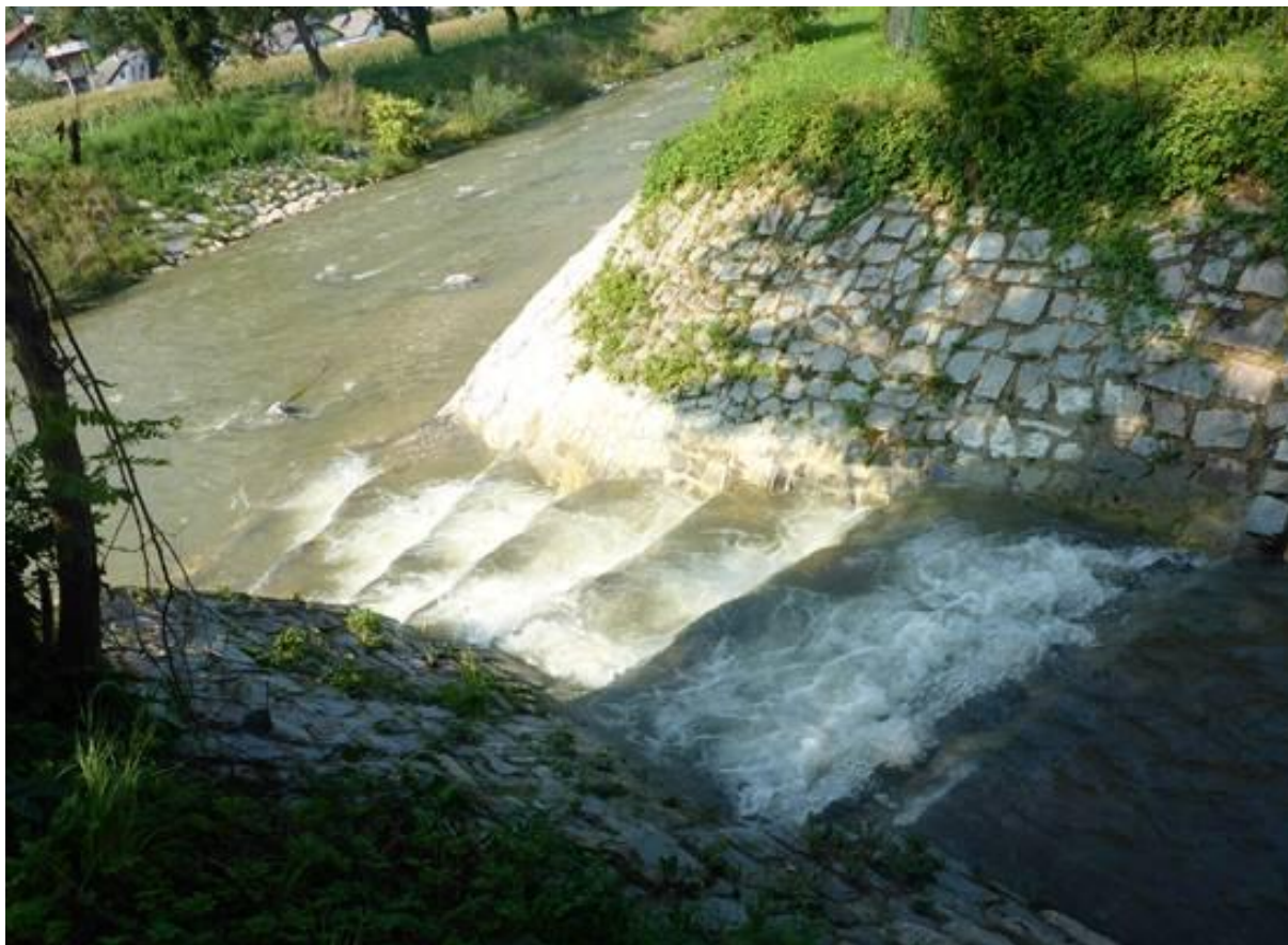
Slika 23: Stopnja na izlivu preoblikovana v kaskadno drčo z več stopnjami. Vodotok: Izliv Barbarskega potoka v Mežo. Foto: arhiv, ZZRS.
