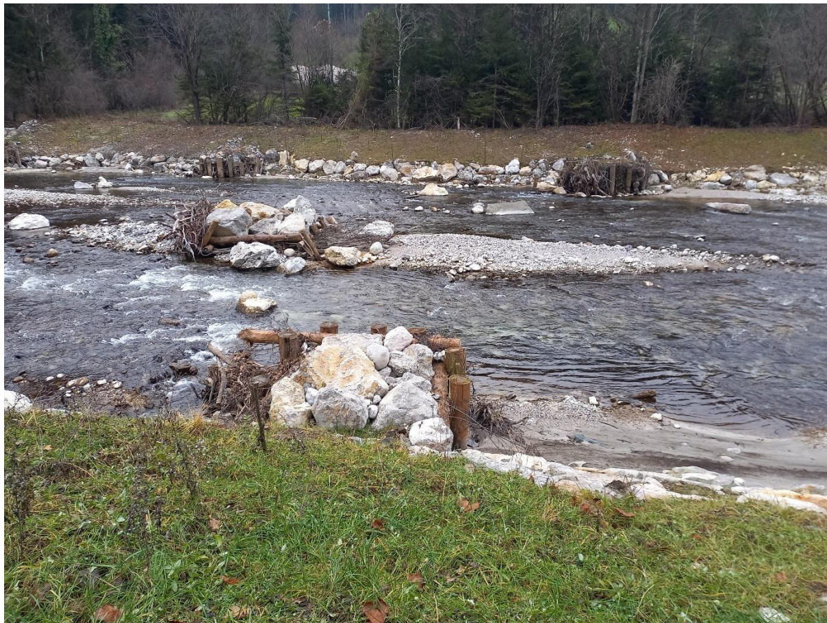
Slika 15. Zavarovanje struge z jezbicami in koreninskimi sistemi. Vodotok: Savinja. Foto: arhiv, ZZRS.
