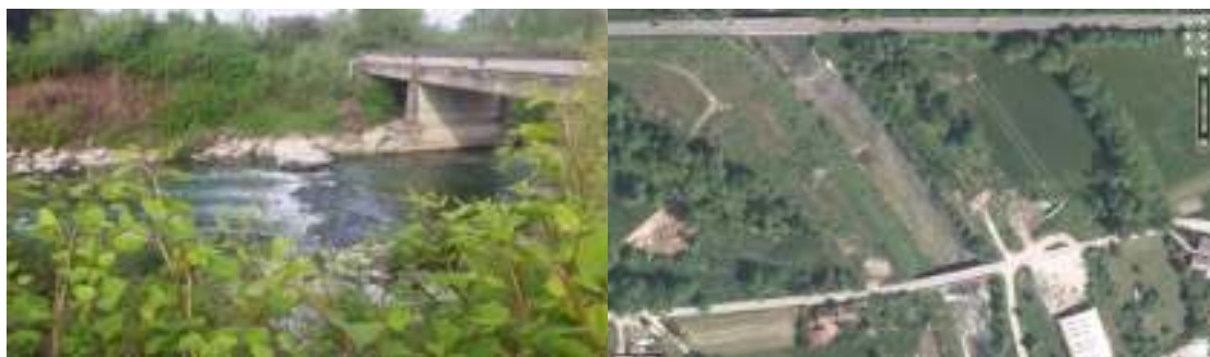
Slika 89: Praga pod cestnim mostom v Beričevem (levo) in odsek Kamniške Bistrice, kjer je za prehajanje, zlasti ob nizkih pretokih, problematičen preizek vodostaj (desno).
