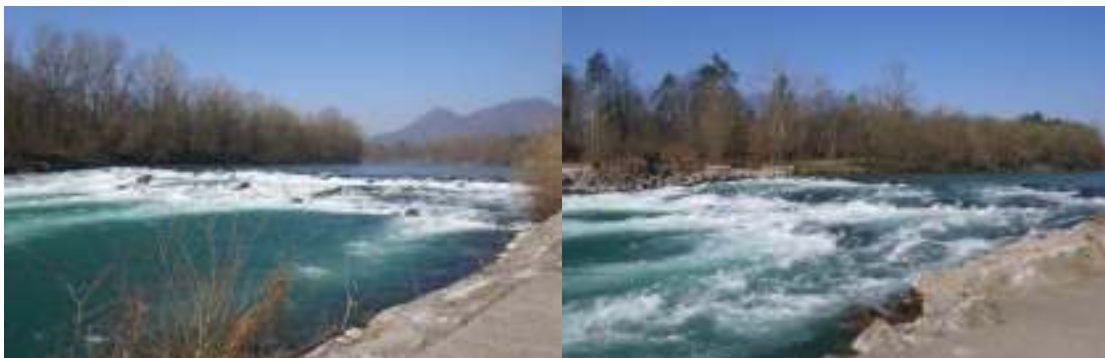
Slika 56: Primera dvostopenjskega kamnitega pragu, ki tvorita hrapavo drčo. Dvojni prag v Spodnjih Gameljnah (levo) in dvojni prag pod izlivom Gameljščice v Spodnjih Gameljnah (desno).
