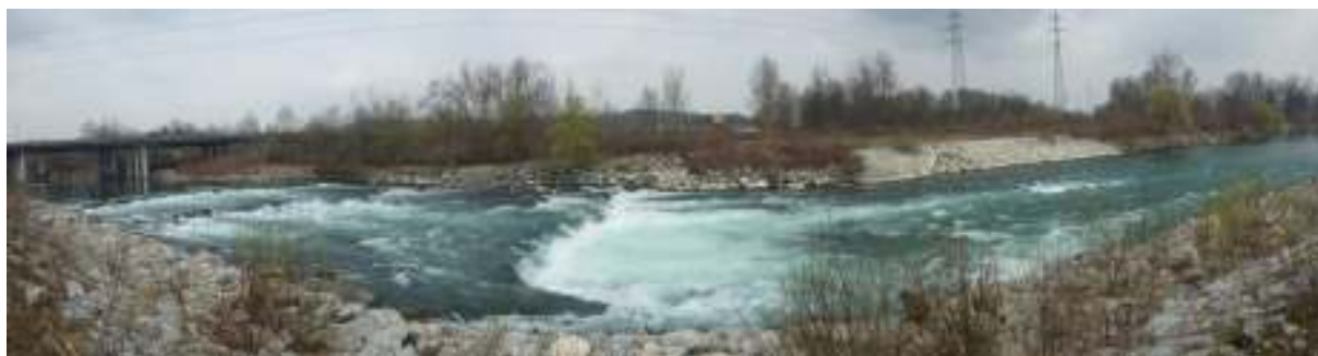
Slika 67: Tristopenjski prag v Šentjakobu (pregrada št. 18).
