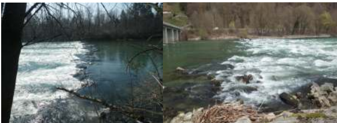
Slika 57: Primera položnih kamnitih pragov brez izrazitih stopenj. Prag v Spodnjih Gameljnah (levo) in prag pod mostom v Kresnicah (desno).
