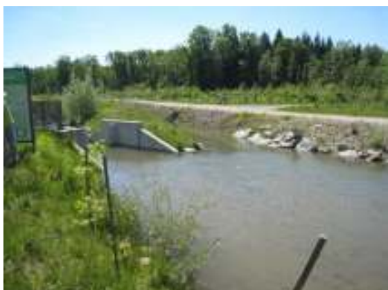
Slika 101: Stičišče obvodne struge in prehoda za ribe – levo in obvodna struga – desno.
