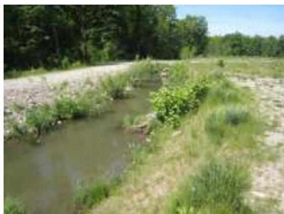
Slika 101: Stičišče obvodne struge in prehoda za ribe – levo in obvodna struga – desno.
