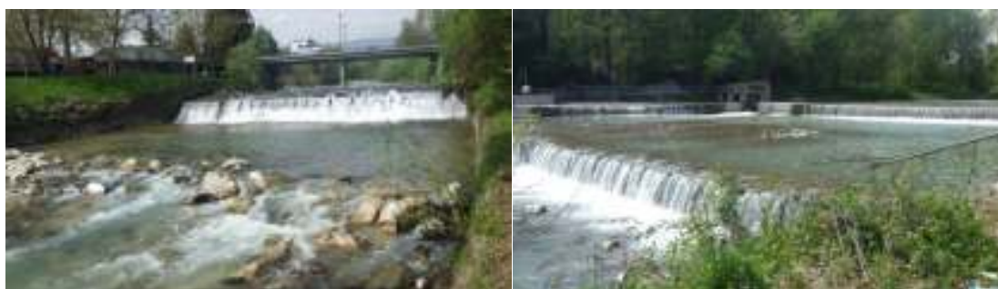
Slika 92: Primeri za sulce neprehodni jezov v Kamniški Bistrici. Jez v Radomljah (levo) in jez v Homcu (desno).
