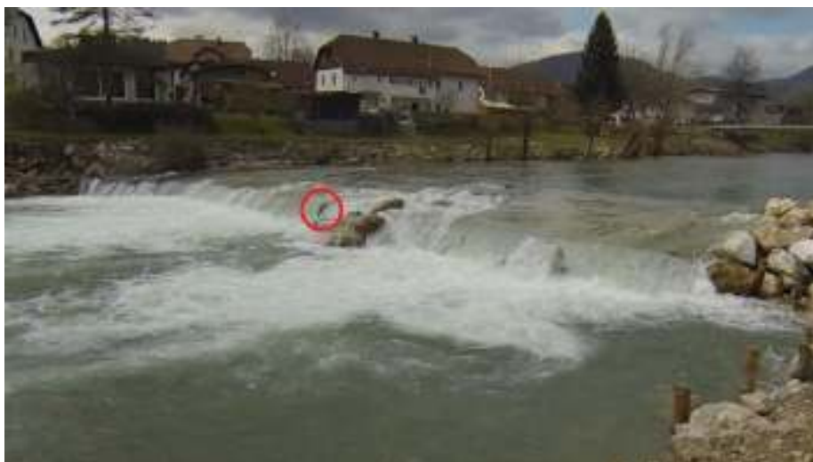
Slika 73: Prag na izlivu Sore v Savo v obstoječem stanju. Na fotografiji je na sredini z rdečim krogom označen sulec, ki želi prag neuspešno preskočiti.
