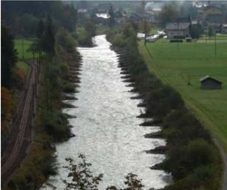
Slika 97: Ukrep za omilitev vpliva koničnega obratovanja na reko. (vir: https://infoscience.epfl.ch/record/187169/files/EPFL_TH5812.pdf )
