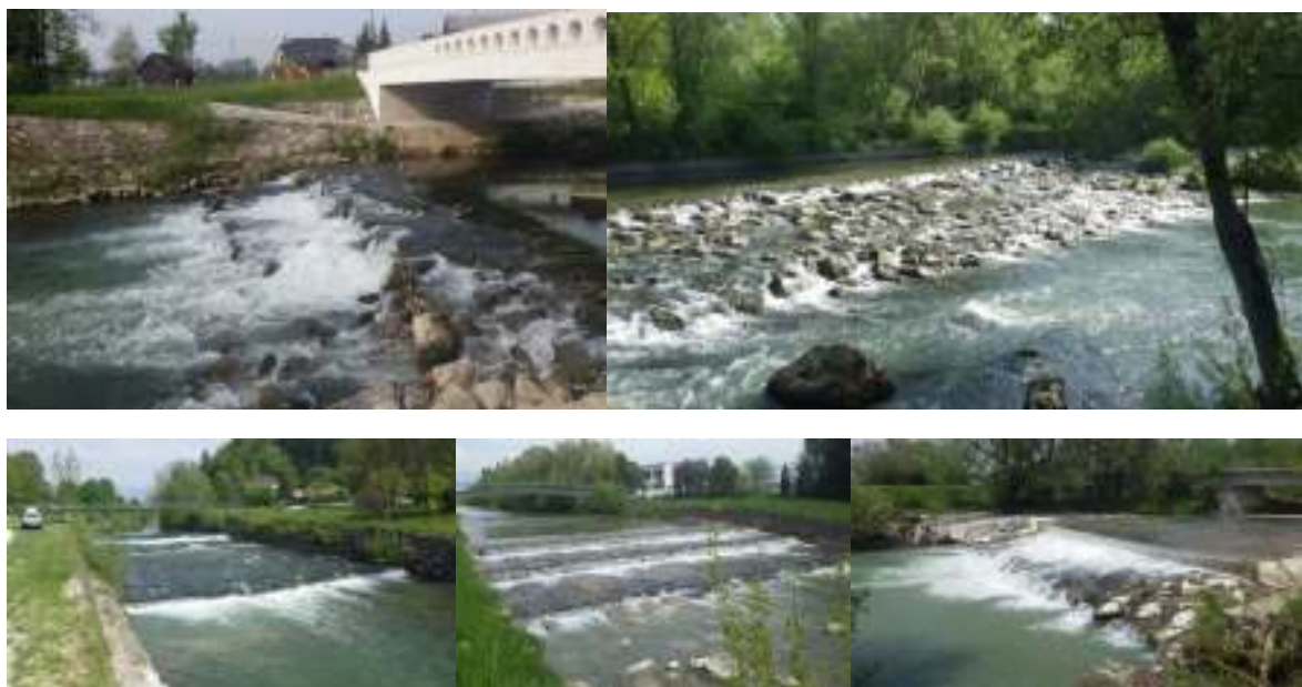
Slika 91: Primeri višjih pragov, ki prehajanje sulca v večjem delu leta onemogočajo.
