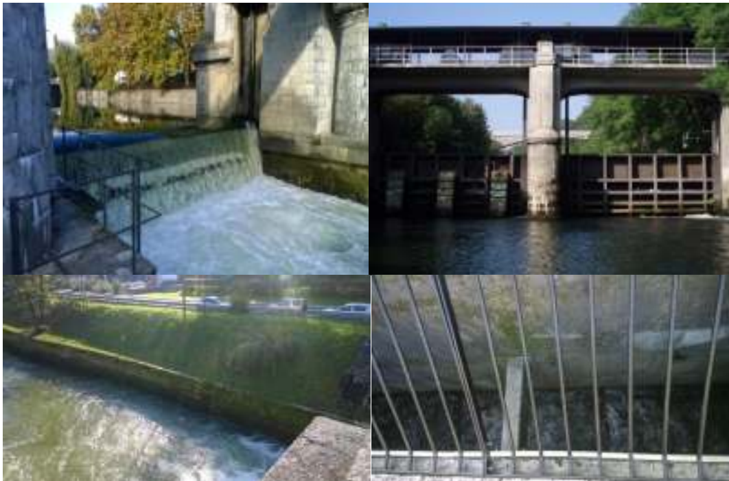
Slika 87: Zapornice pri Ambroževem trgu (zgoraj levo) in na Gruberjevem kanalu (zgoraj desno). Vhod v prehod za ribe (spodaj levo) in tehnični tip prehoda za ribe (spodaj desno) na pregradi pri Ambroževem trgu.
