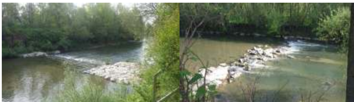
Slika 90: Primeri nizkih za sulce prehodnih talnih pragov v Kamniški Bistrici.
